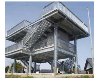
〔津波避難タワー〕
