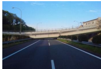
③九州自動車道（益城バスストップ付近） 本線上の跨道橋が落下
