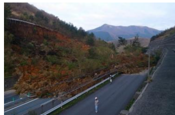
①大分自動車道（由布岳PA付近） 道路法面の土砂が崩落
