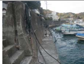
②護岸状況
