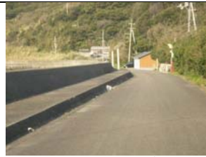
②護岸状況
