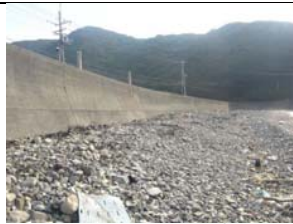
③護岸状況
