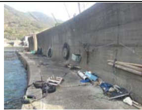
②護岸状況
