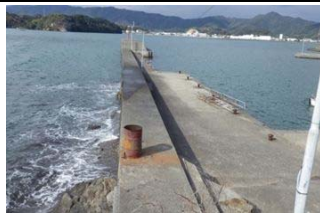
②堤防状況
