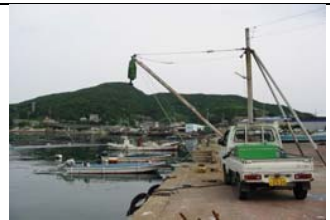
②護岸状況
