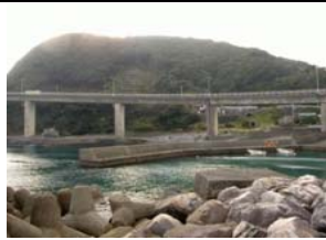
③護岸状況
