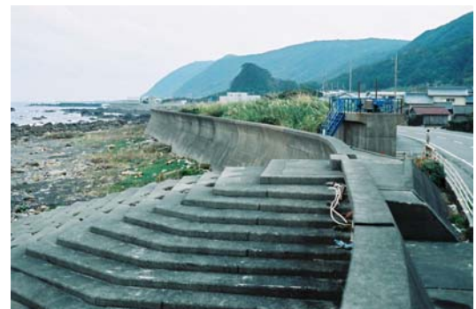
〔緩傾斜堤 (室戸市丸山海岸)〕
