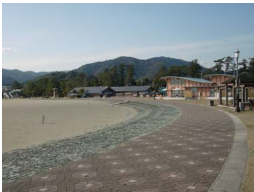
〔甲浦港海岸・白浜地区（東洋町）〕
