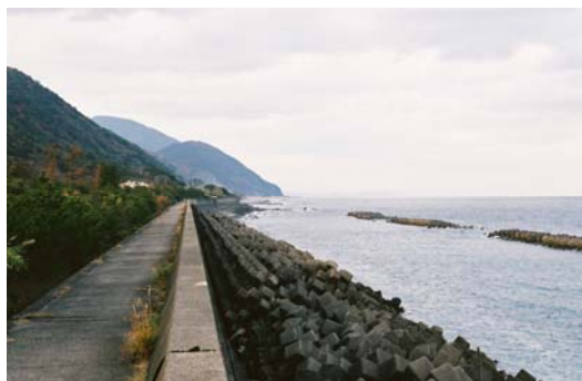
〔消波工と離岸堤 (室戸市根丸海岸)〕
