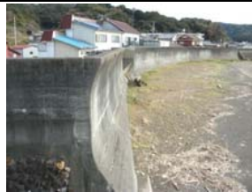
②護岸状況
