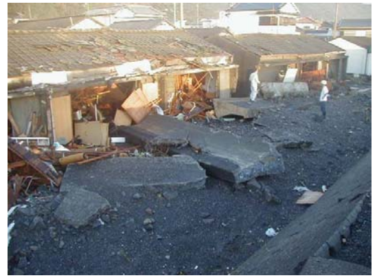
〔菜生海岸被災状況（室戸市）〕
