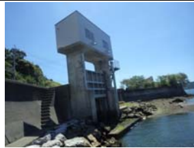
②水門状況
