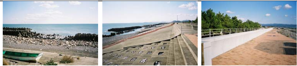
①海岸状況 ②護岸状況 ③背後地状況
