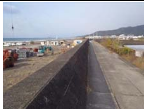
②護岸状況
