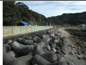
②護岸状況
