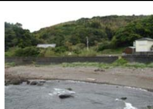
③護岸状況
