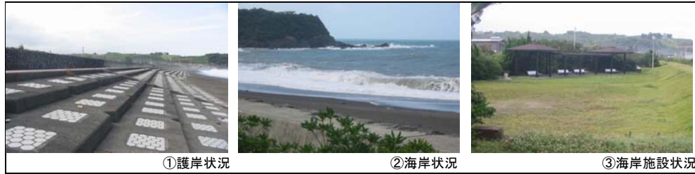
①護岸状況
