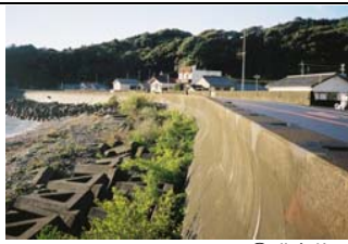
③護岸状況
