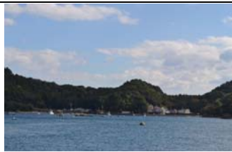
②護岸状況
