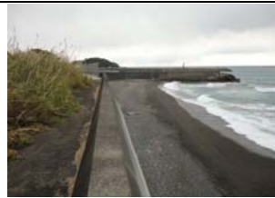
③海岸堤防状況
