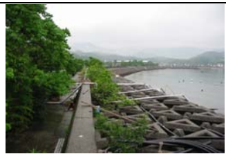
②護岸状況
