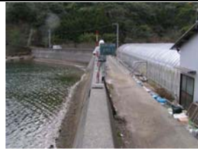
②護岸状況
