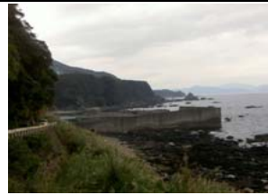
③護岸状況
