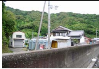
②背後地状況(深戸地区)
