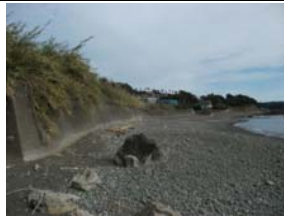
②護岸状況
