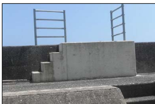
〔陸閘常時閉鎖 事例〕
