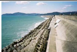
③護岸状況
