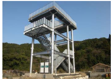
〔津波避難タワー（四万十町）〕
