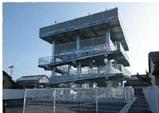
津波避難タワー
