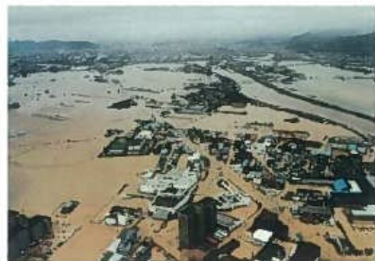
'98 高知豪雨による浸水状況 (高知市大津地区周辺)
