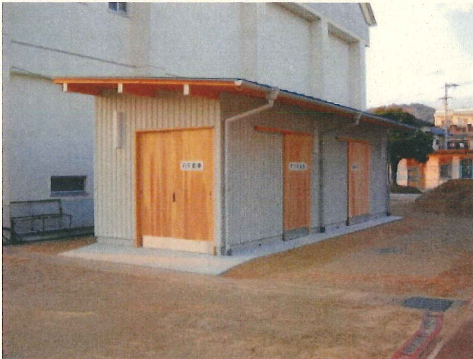
完了(体育器具庫)
