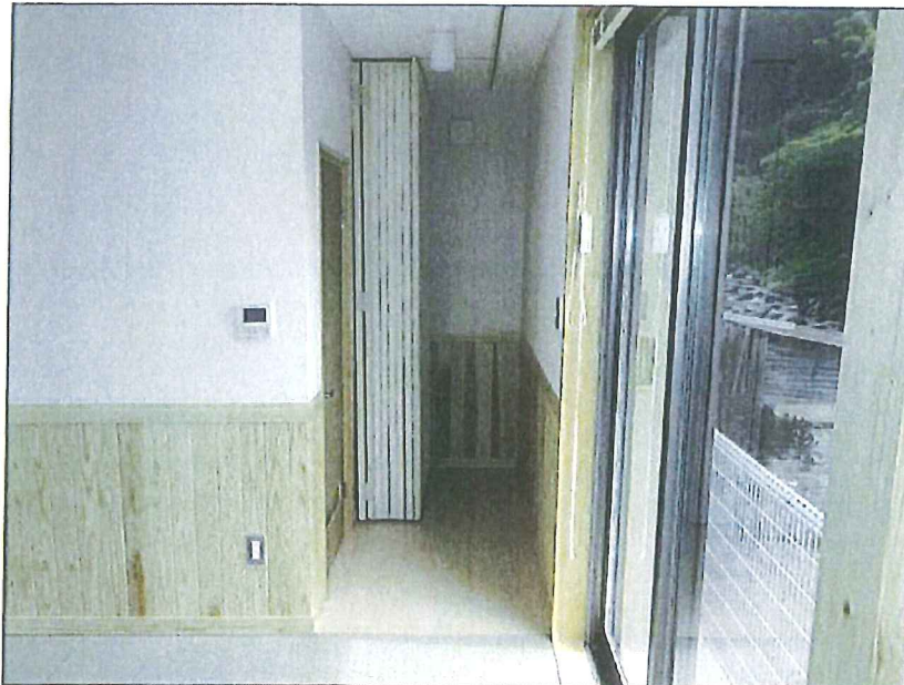
移動間仕切り収納部
