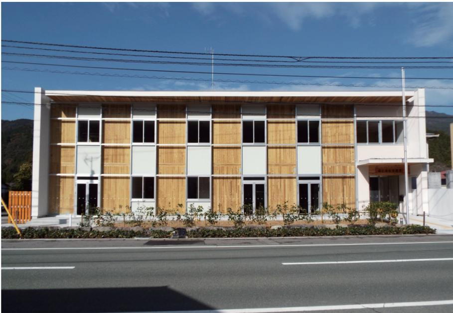
外壁をガラスとし、構造用CLTパネルを見せる
