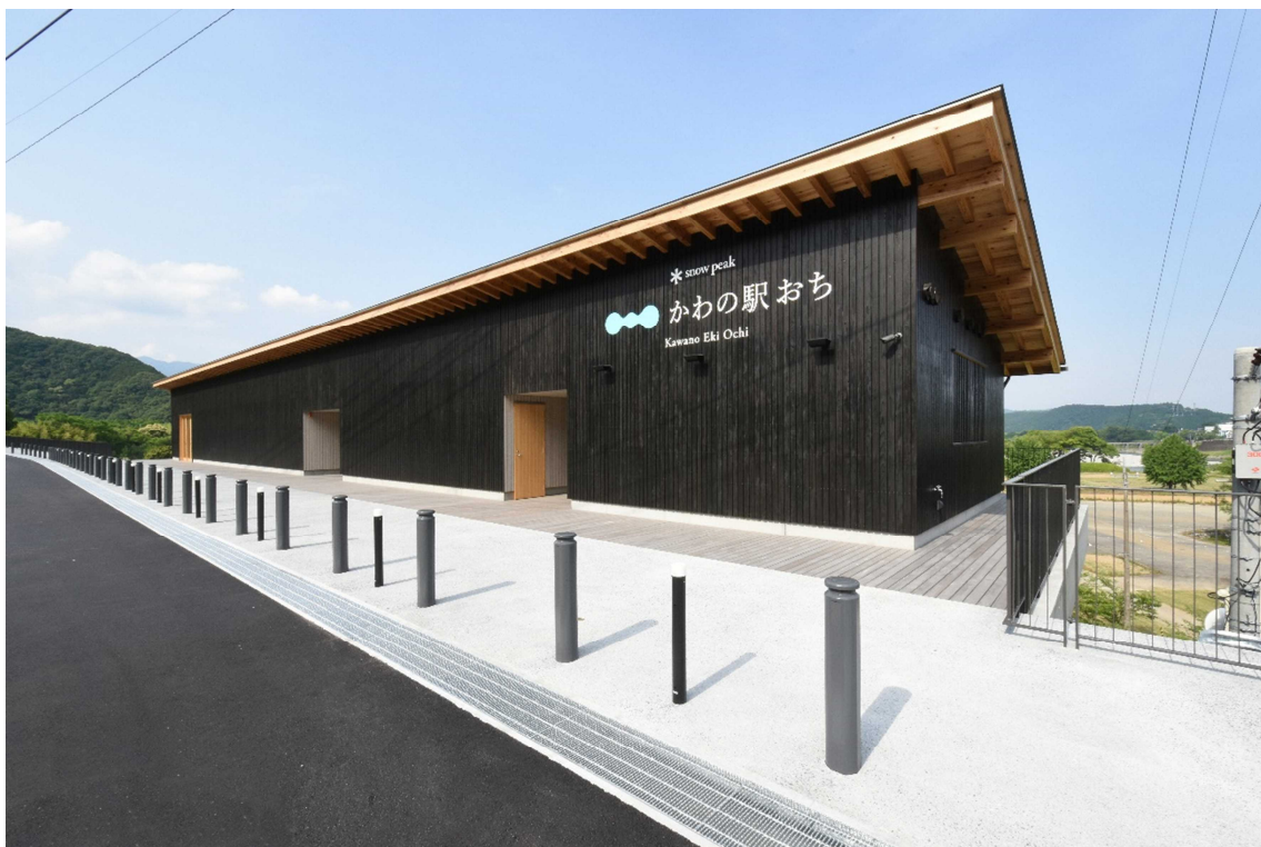
国道側からの2階部分
