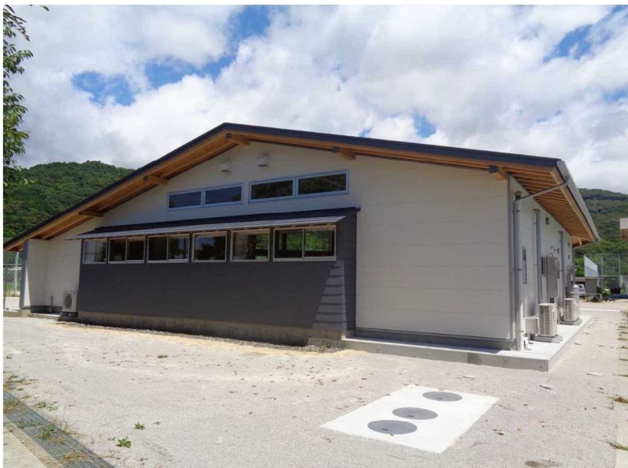
施設外観（南東面）
