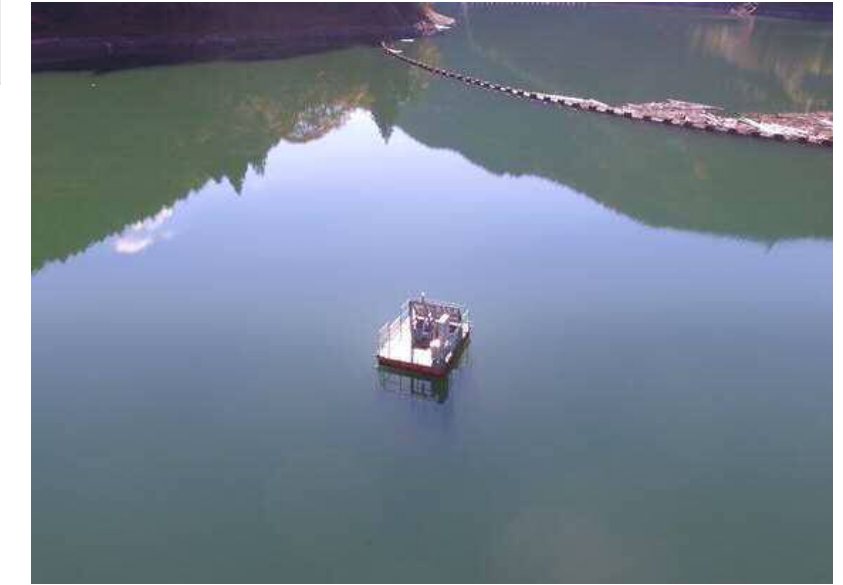
▲自動濁度計 全景
