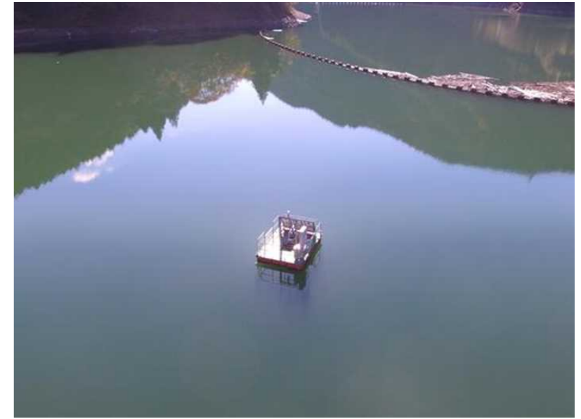
▲自動濁度計 全景
