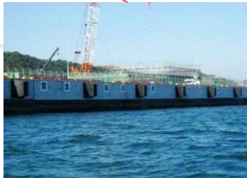
<三里4号岸壁 (-11.0m)>
