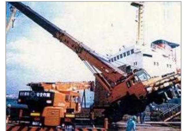
岸壁の陥没によるクレーンの倒壊事故
