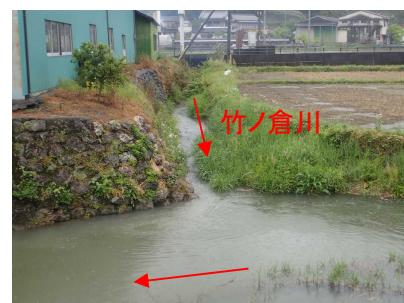
(4) 長竹橋が水の流れを阻害している
