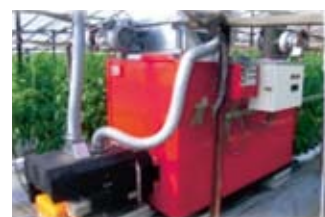
木質バイオマスボイラー
