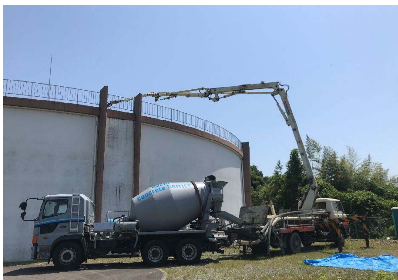
図 6-11 南部配水池耐震補強工事
