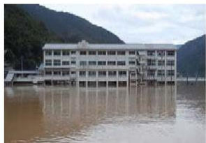
H26.8避難所2階の浸水 (徳島県)
