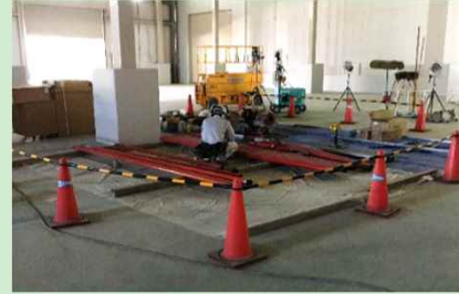
工事エリアの区画を設定して作業
