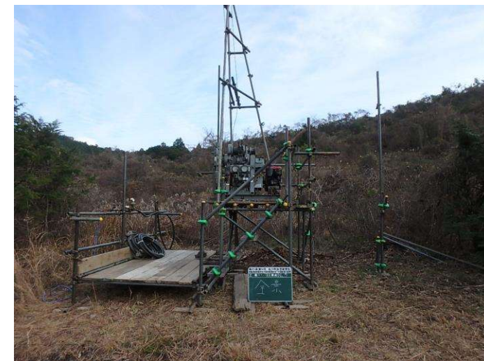
ボーリング機械の設置状況
