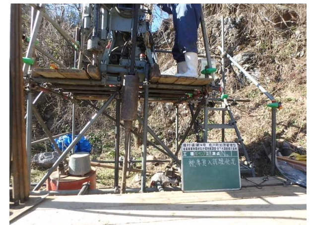
掘削等の状況
