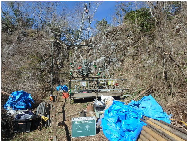
ボーリング機械の設置状況
