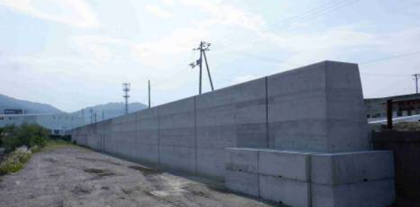
潮江地区 港町工区 本体工(R5.5撮影)
