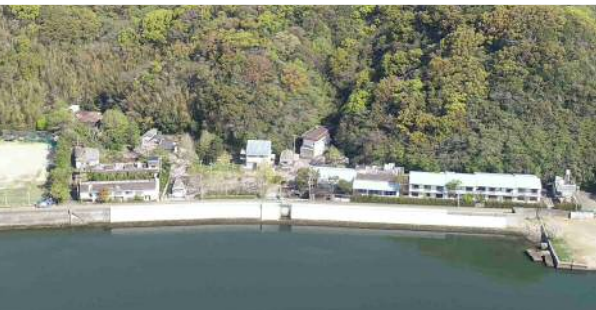
浦戸湾地区 横浜工区 本体工(R5.3撮影)
