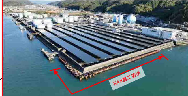
タナスカ工区 北護岸・西護岸 本体工(R4.12撮影)
