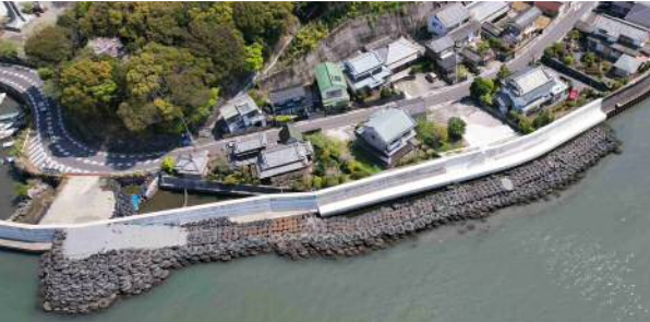
高須地区 吸江工区 本体工(R5.4撮影)
