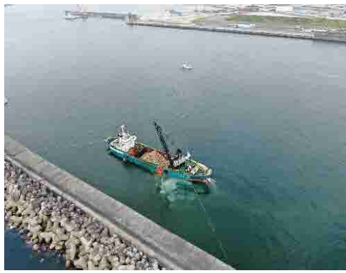
①防波堤(東第一)(直轄施工) 腹付工(R4.8撮影)
