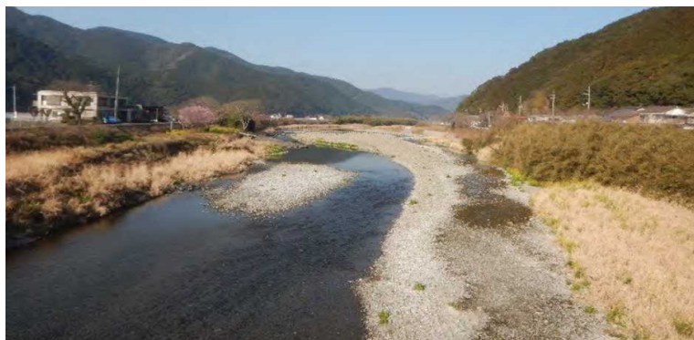
長竹橋（1.3km）から上流を望む 【新莊川の現況】
