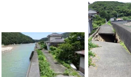
古満目漁港海岸の海岸堤防
