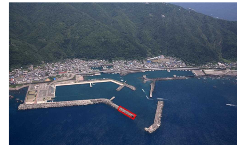
室戸岬漁港 沖防波堤の粘り強い化整備
