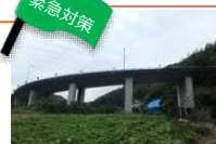
国道195号 山崎陸橋
