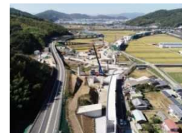
高知東部自動車道 高知南国道路（高知市）
