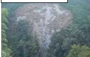
治山対策例 (施工前)
