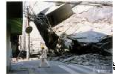
【倒壊した建築物による道路の閉塞状況】
