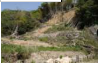
治山対策例(施工前)
