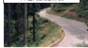
林道開設施工後
