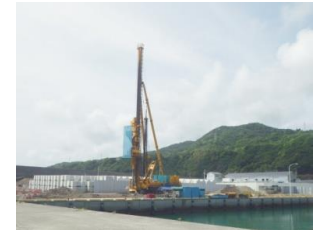
防災拠点漁港の岸壁耐震化
