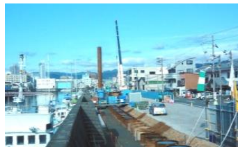
海岸堤防の耐震補強状況
