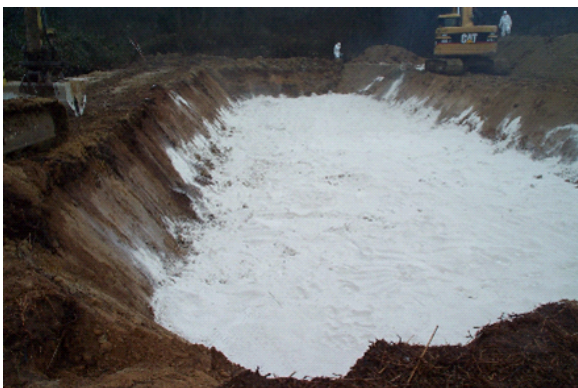
埋却溝内への消石灰散布
