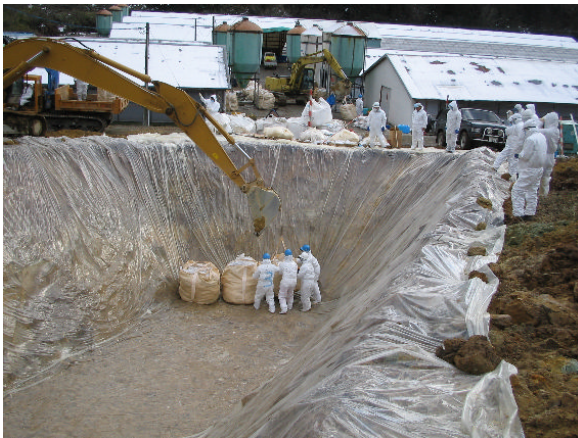
埋却溝内への汚染物品の敷設
