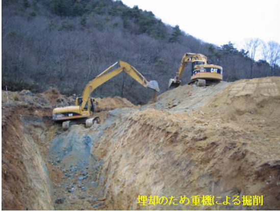
重機を用いた埋却場所の掘削
