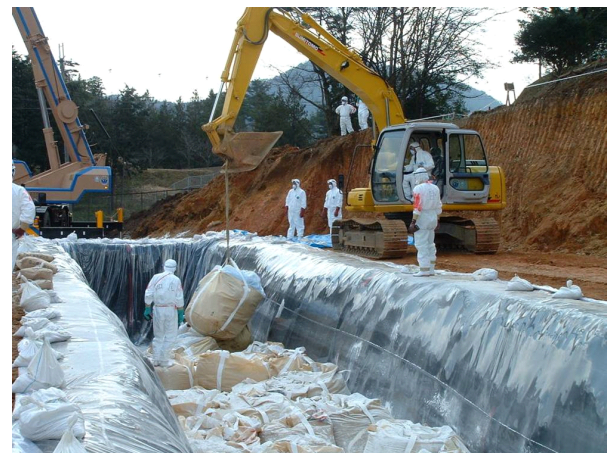
埋却溝内への汚染物品の敷設
