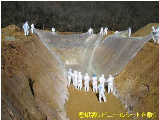
埋却溝内へのビニールシートの敷設
