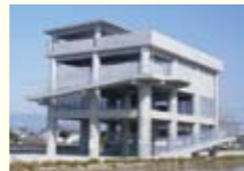
津波避難タワー
