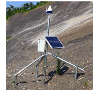
GNSSによる観測状況
