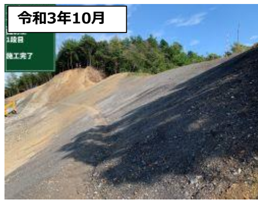
1:2.0勾配斜面 施工直後の状況
