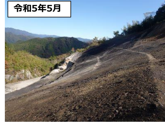
1:2.0勾配斜面 施工後1年7カ月以上
