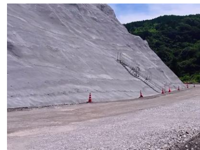
工事用道路の整備状況
