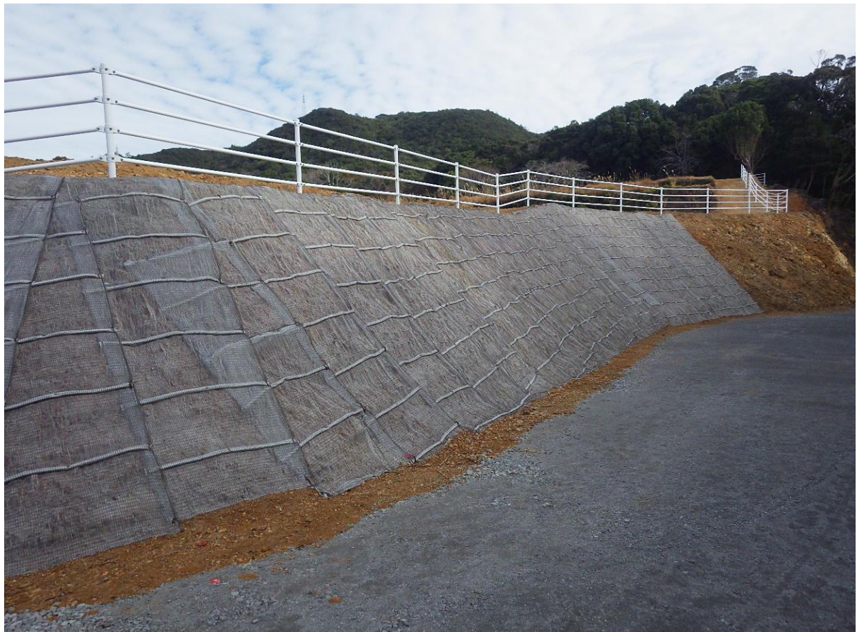
ため池改修(妙見山池) 工事用道路 L=111.0m W=4.0m
