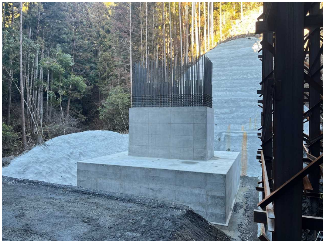
橋梁下部工 P1橋脚(1期施工) N=1基
