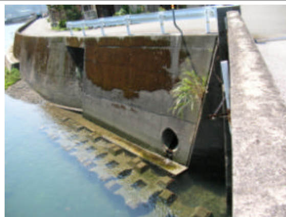
写真 7-8 上ノ加江川への排水口
