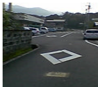
写真 7-40 消火栓 (上ノ加江スーパー付近)
