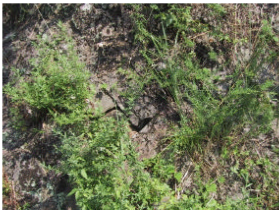
写真 7-17 農協集荷場南付近 (石材間の空隙により不安定)
