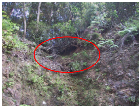
写真 7-14 上ノ加江バス停南西付近 (亀裂発達に伴う浮石化)
