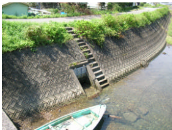
写真 7-9 上ノ加江川への排水口
