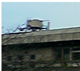
写真 7-39 スピーカー (漁港屋上)
