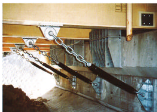
図 7-55 装落橋防止装置の例
