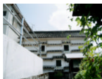
写真 5-3 地域内の土蔵
