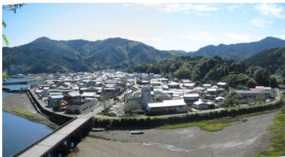
写真 5-1 上ノ加江橋（北側）より望む
