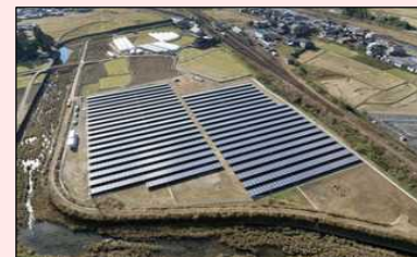
県も出資している県内の太陽光発電施設
