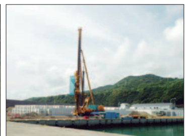
〔耐震強化岸壁の整備〕
