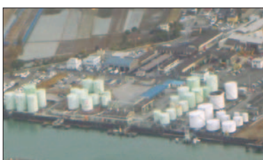
〔タナスカ地区石油・ガス基地〕
