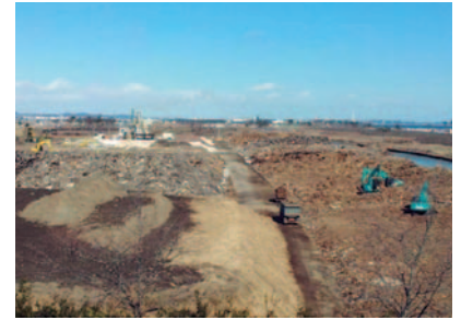
災害廃棄物の処理
