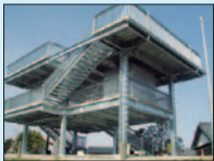
〔津波避難タワー〕
