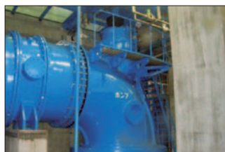
(排水機場の耐震化)
