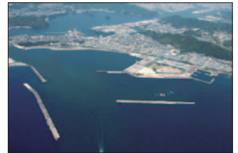
(高知新港防波堤)
