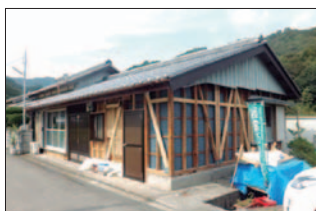
(耐震改修工事中の木造住宅)
