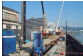
(国分川堤防耐震化)
