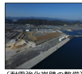
〔耐震強化岸壁の整備〕
