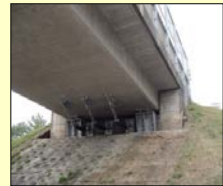
〔落橋防止装置の設置〕
