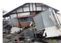
〔熊本地震により倒壊したブロック塀と住宅〕
