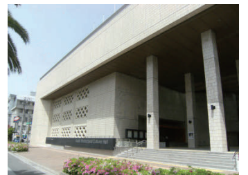
〔耐震化後（県民文化ホール）〕
