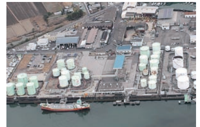
〔タナスカ地区石油・ガス基地〕
