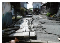
〔熊本地震により倒壊したブロック塀と住宅〕
