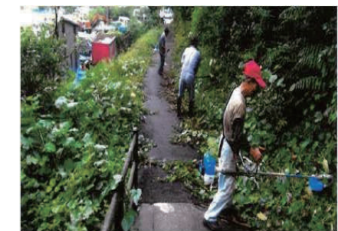
【避難路の整備】
