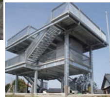
〔津波避難タワー〕
