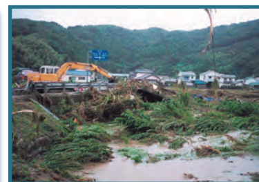
流木堆積状況
