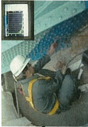
超音波による非破壊検査
