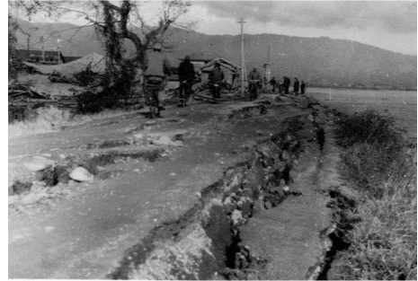
昭和 21（1946）年昭和南海地震翌日の堤防の液状化被害の様子（沢村武雄・上田寿 高知大学名誉教授撮影）
