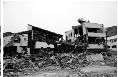
汀線で約15mの津波高が観測された宮城県女川町の様子（平成23年4月26日）
