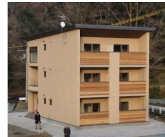
日本初のCLT建築物 (高知おおとよ製材社員寮)
