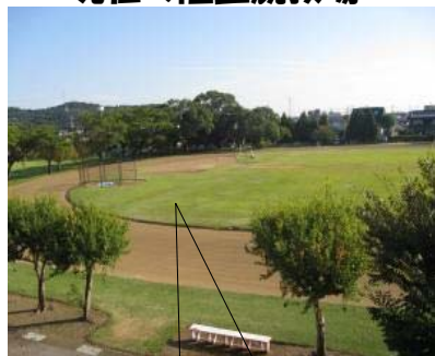
土質・芝が剥離状態
