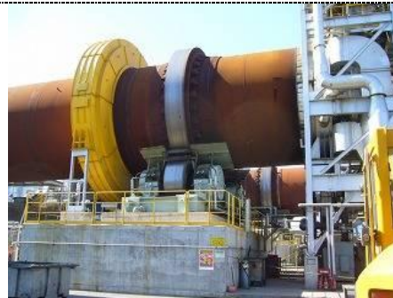
▲石巻ブロックのロータリーキルン炉
