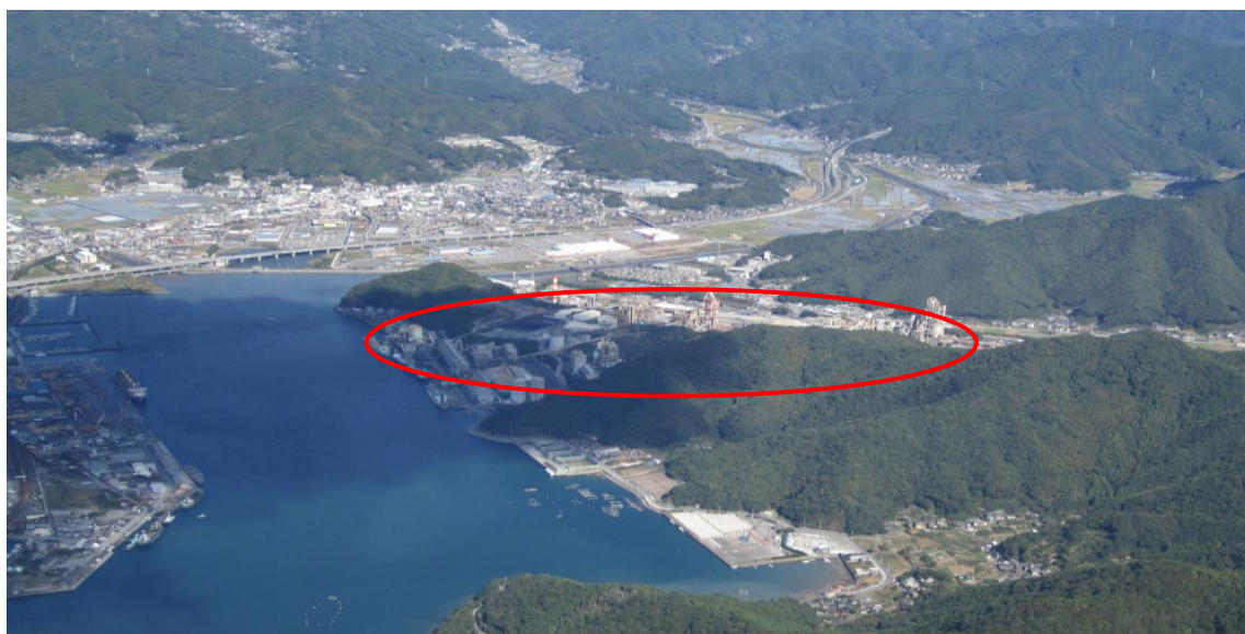
図 3.5.3 臨海部に位置するセメント製造工場 (H25. 10. 16 撮影)
