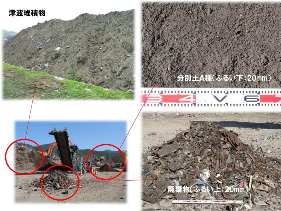
図 5.7.1 津波堆積物のふるい選別(乾式分級)の例
