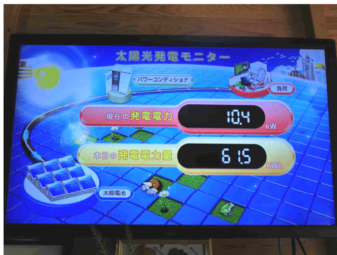
甫喜ヶ峰森林公園に設置されたモニター
