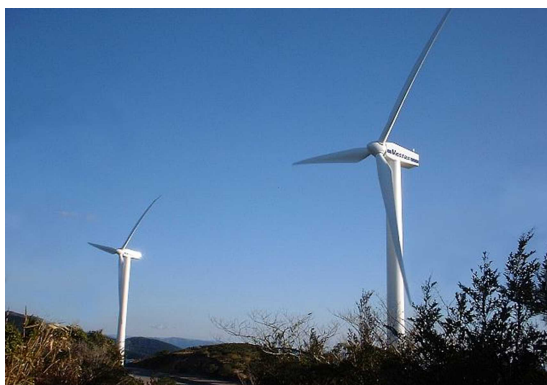
甫喜ヶ峰風力発電所(香美市土佐山田町)
