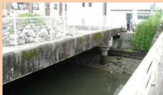
駐車場撤去部(撤去前)
