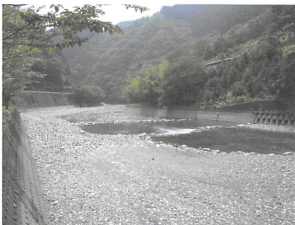
図5 5区（木製構造物区） 湍 （図2 Bより H19_06_27 撮影）
