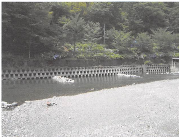
図4 4区（石構造物 水制工） トロ （図2 Bより H19_06_27 撮影）
