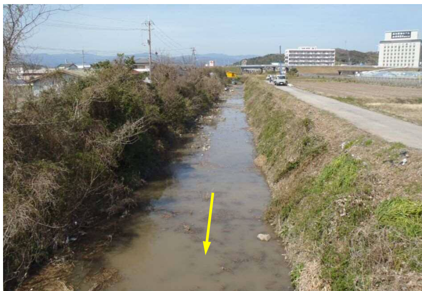
未修区間の河道状況（烏川：野市跨線橋下流付近）
