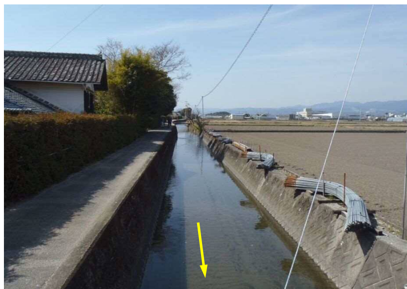
未修区間の河道状況（下井川）
